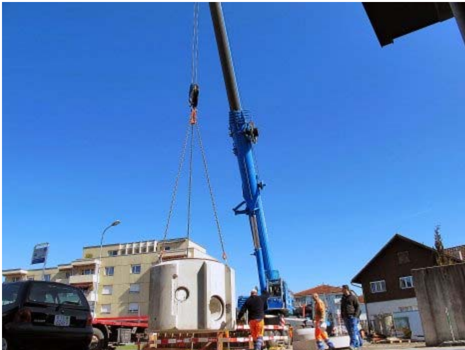
Der 15 Tonnen schwere Vereinigungsschacht wird versenkt.
